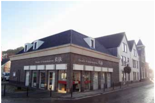
Advieskantoor Rijk te Kruiningen
