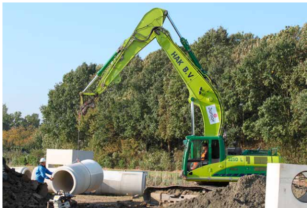
Voor de afvoer van het overtollige regenwater naar de Molenpolder zijn er forse buizen nodig.
