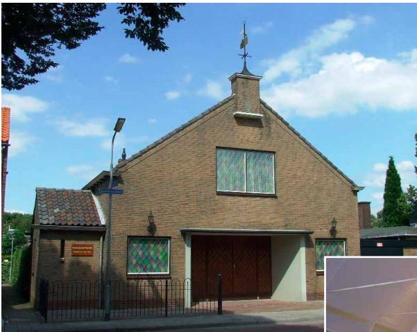
Kerkgebouw van de Geref. Gemeente te Rilland.
